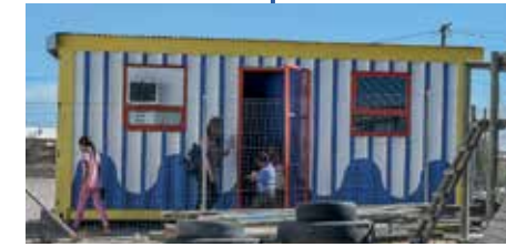
Alter Schiffscontainer auf dem Schulgelände wird von der Stiftung saniert & dient als Basislager unseres Volontärteams
